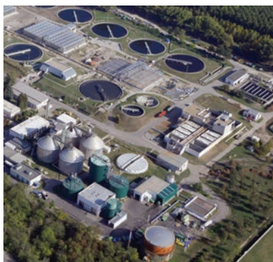
3. Szennyvíztisztító telep. A nagy méretű medencékben baktériumok tömege távolítja el a vízből a szennyező anyagokat
