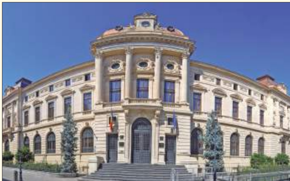
Clădirea Băncii Naționale a României
