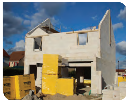
■ Ytong falazóelemekből épülő ház
