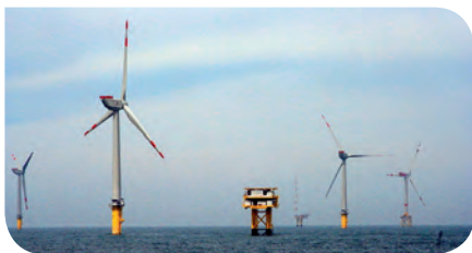
■ Tengeri szélerőműtelep Németországban az Északi-tengeren (Borkum Riffgrund 1)
