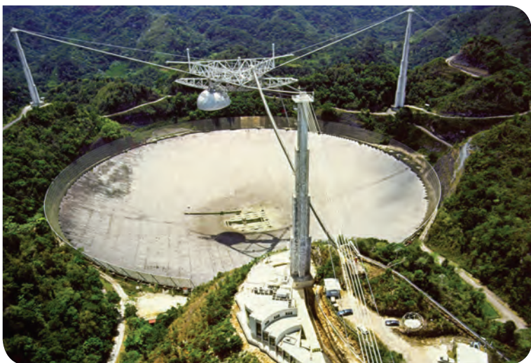
■ Az arecibói rádiótávcső óriási parabolaantennája egy vulkán kráterében épült
