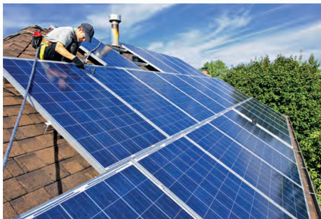
Napelemek szerelése háztetőre
