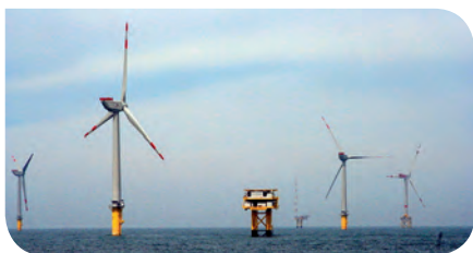
■ Tengeri szélerőműtelep Németországban az Északi-tengeren (Borkum Riffgrund 1)
