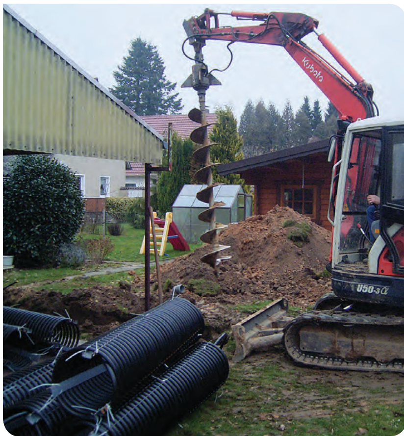
■ A kb. 2 méter magas és fél méter átmérőjű spirálcsövek kétméterenként függőlegesen lesznek a földbe helyezve
