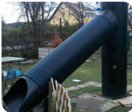
■ A fekete csőben felmelegedett víz folyik vissza a csúszdán át a medencébe
