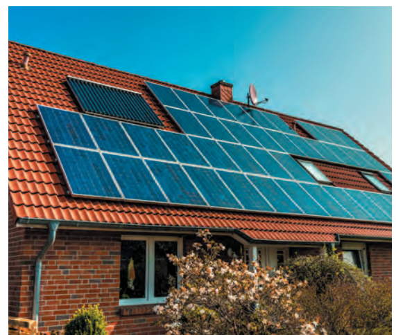
Napelemekkel és napkollektorral borított háztető
