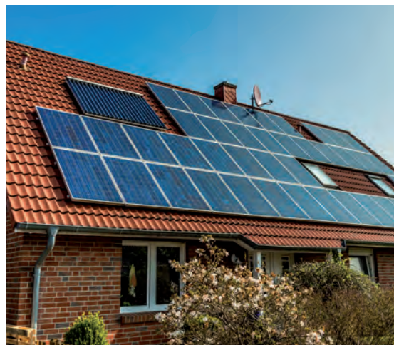
Napelemekkel és napkollektorral borított háztető
