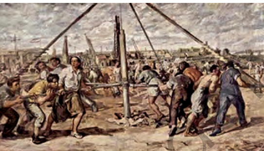
Божа Илић: Сондирање терена на Новом Београду (1948)
